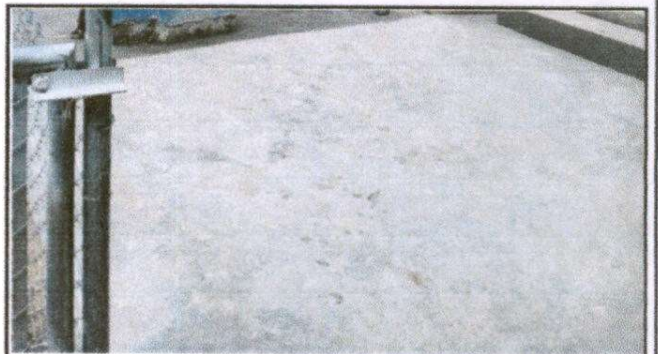
Foto 10: Reparación de Losa de patio 16 M2
