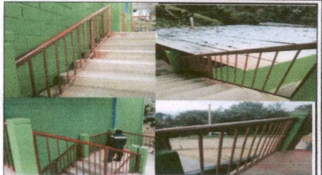
Foto 8: Mantenimiento a barandas de metal 50 M2
