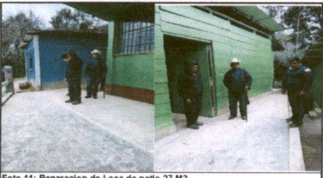
Foto 11: Reparación de Losa de patio 27 M2
