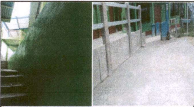
Foto 9: Reparación de muro perimetral de block. 22 M2
