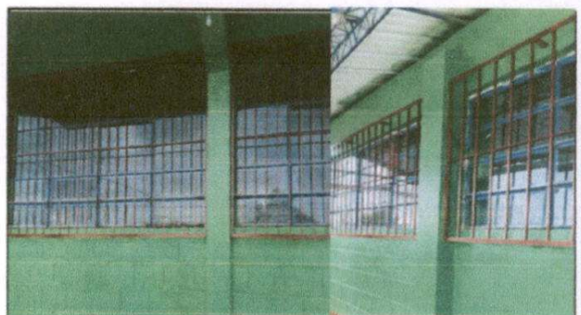
Foto 4: Mantenimiento a balcones de metal 50 ML
