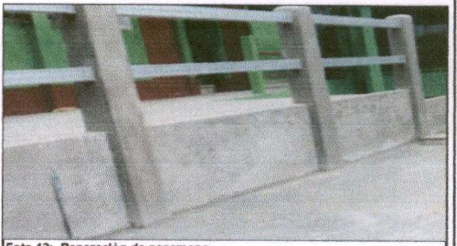
Foto 12: Reparación de pasamano
